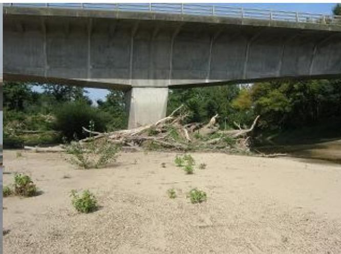
*Figure 5. Embâcle (septembre 2007) contre la 1ere pile rive droite encombrant l'entrée du bras Saint-Aubin*
